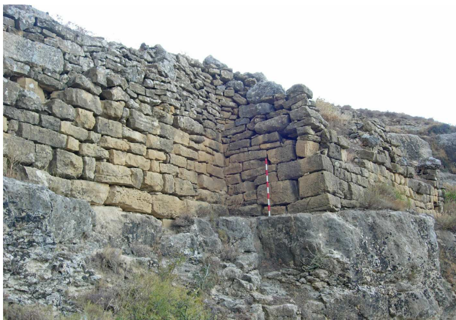
▲ Fig. 4. Tramo de la muralla situado al norte de la puerta.
